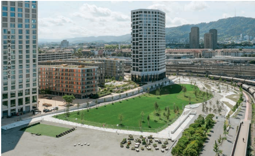
Gegensätze prägen die Ränder des Pfingstweidparks in Zürich: Wohnhochhäuser auf der einen, das Gleisfeld auf der anderen Seite. Fotos: Schnitzelcopter
